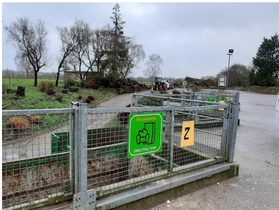
Déchetterie située à Carhaix
