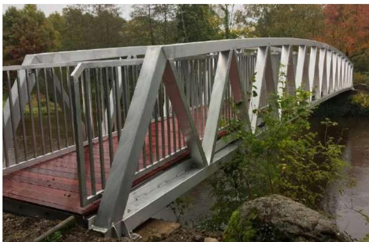
*Nouvelle passerelle en structure aluminium – bois*
